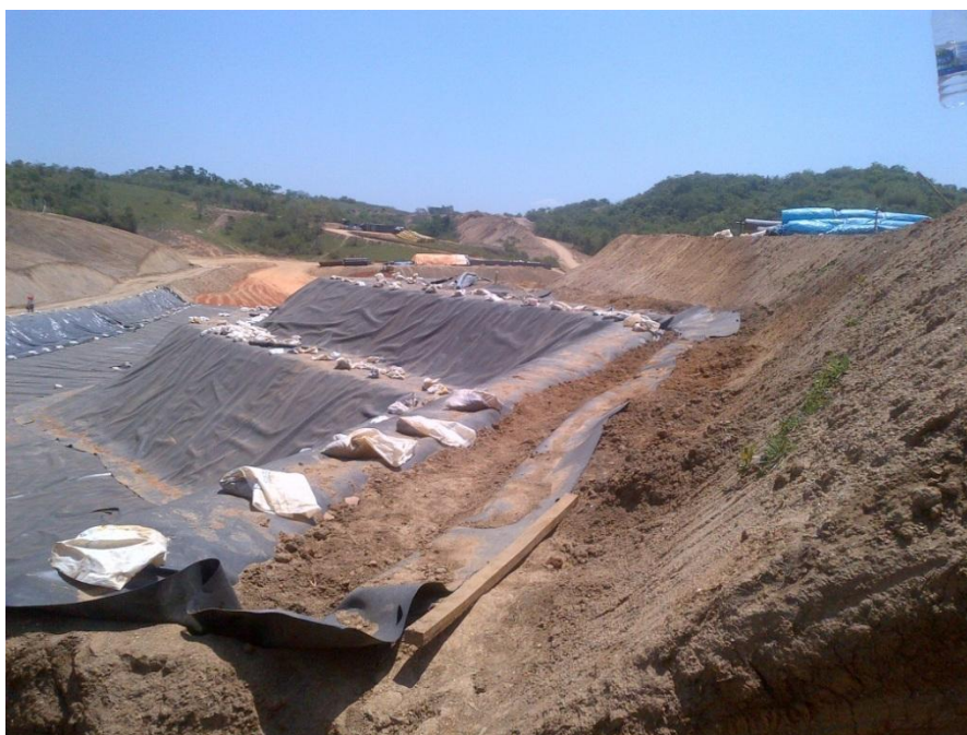
Figura 6.5.9.2.2-1: Exemplo da geomembrana lançada na fundação de um aterro sanitário (Fonte: CTR Alcântara – São Gonçalo/RJ - HAZTEC)
