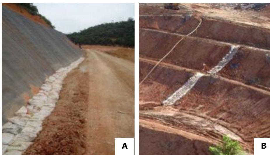
Figura 6.5.6.2.2.1-1: (A) Drenagem provisória com sacos de areia na estrada de acesso junto à geomembrana; (B) Drenagem provisória com sacos de areia em talude provisório.
