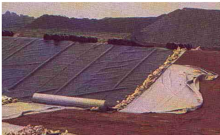
Figura 6.5.9.1-5: Esquema de Lançamento da Geomembrana de PEAD.
