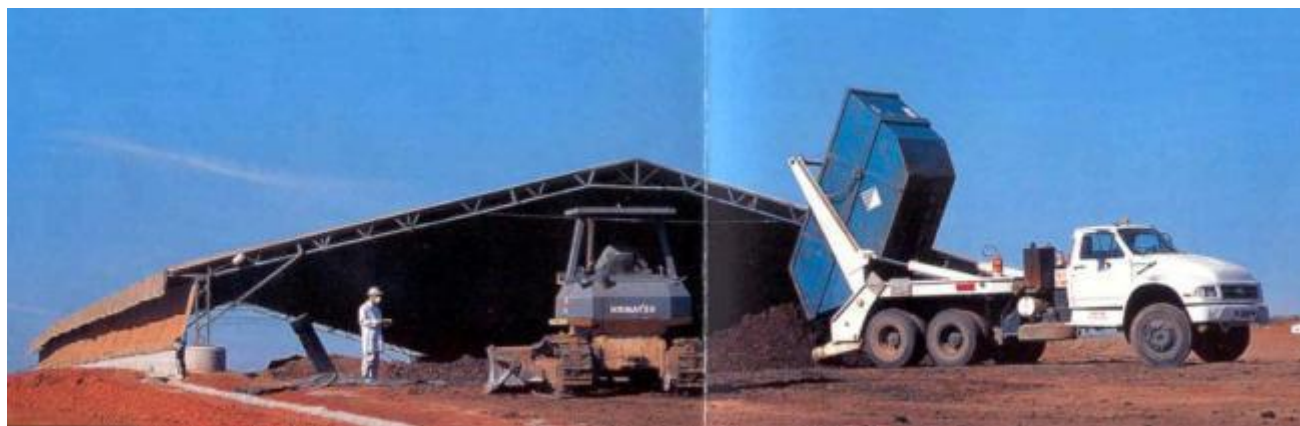
Figura 6.3.3.1.3.3-1: Exemplo de um sistema de cobertura provisória prevista para as células.
