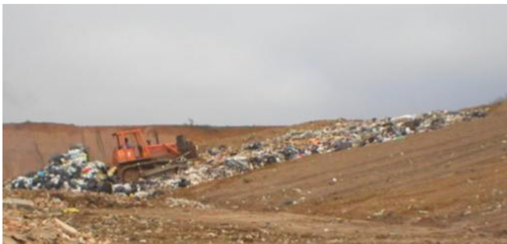
Figura 6.3.3.2.2-2: Exemplo de Lançamento e Compactação de Resíduos em um Aterro Classe II (Fonte: Aterro Sanitário de Guarulhos – Quitauna).
