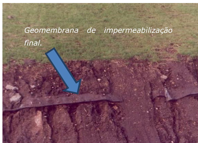
Figura 6.8.5-1: Detalhe da cobertura final prevista para o encerramento da CTR Terra
