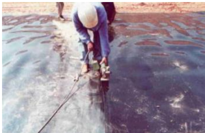
Figura 6.5.9.1-7: Detalhe da soldagem térmica da geomembrana.
