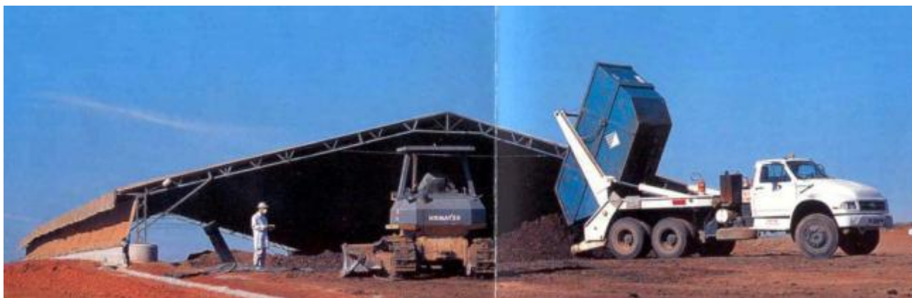
Figura 6.5.7.1-2: Exemplo de um sistema de cobertura provisória prevista para as células.
